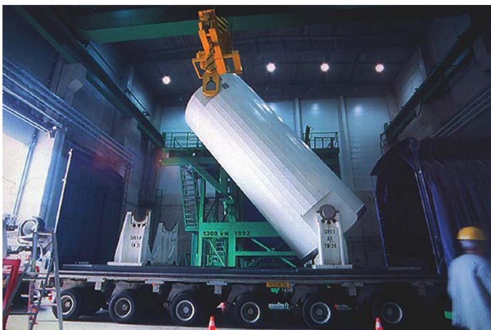
Bâtiment d'entreposage de déchets vitrifiés
