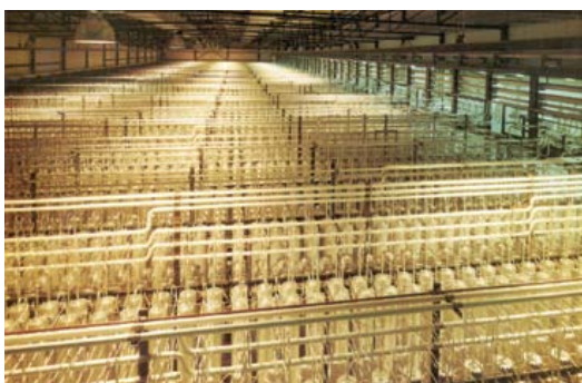
Urenco (Allemagne): installation d'enrichissement en U 235
